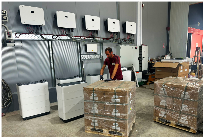
Οι μπαταρίες μπορούν να εγκατασταθούν γρήγορα και εύκολα χάρη στον αρθρωτό (modular) σχεδιασμό τους.
